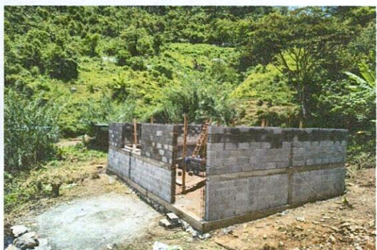
Foto 3: mejoramiento de pared
