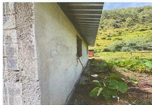
Foto 6: mejoramiento de pared con repello
