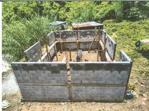
Foto 2: colocacion de block
