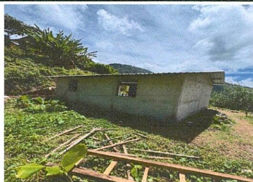
Foto 4: mejoramiento de cubierta de lámina
